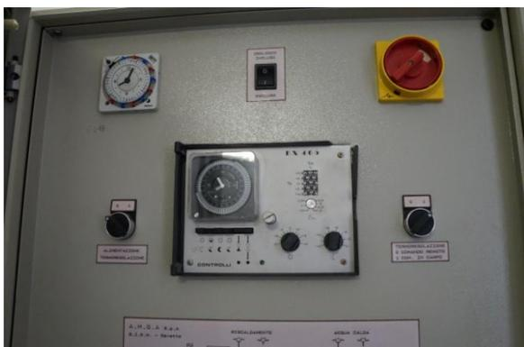
Figura 4.8 - Centralina di controllo in CT
